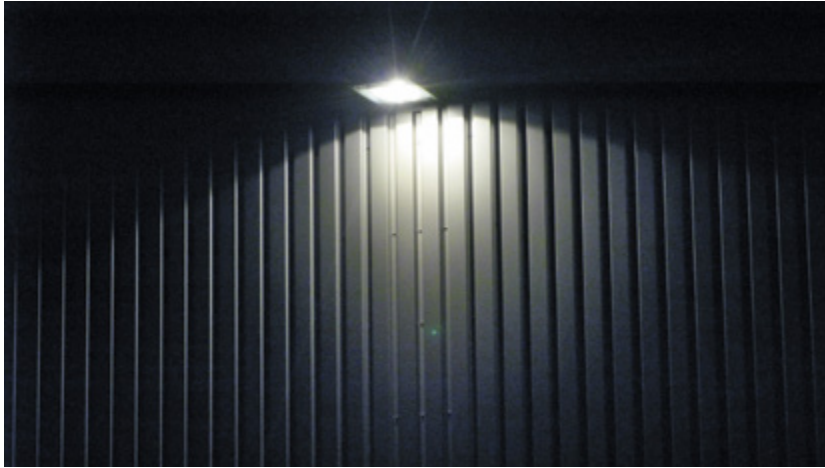
Abb. A8: Full-Cut-Off Leuchte, bei der der enge, nach unten gerichtete Lichtkegel sichtbar ist. Foto: Projekt Sternepark Schwäbische Alb.
