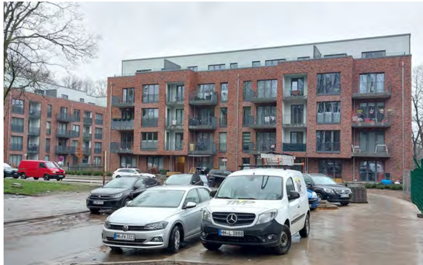
August-Krogmann-Straße 100, SAGA Typenbau Quelle: Bezirksamt Wandsbek
