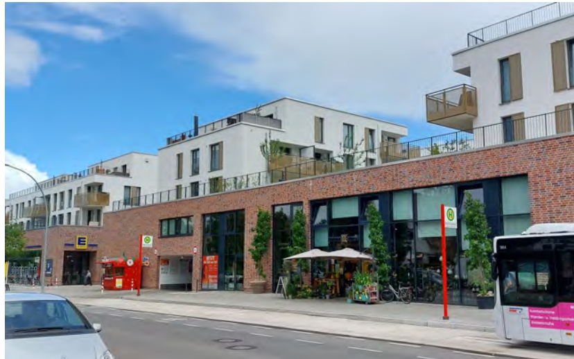
Aufstockung EKZ Meiendorf Quelle: Bezirksamt Wandsbek
