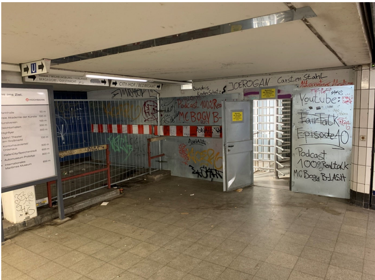
Baustelle Johann Kontor: gesperrter Treppenaufgang
