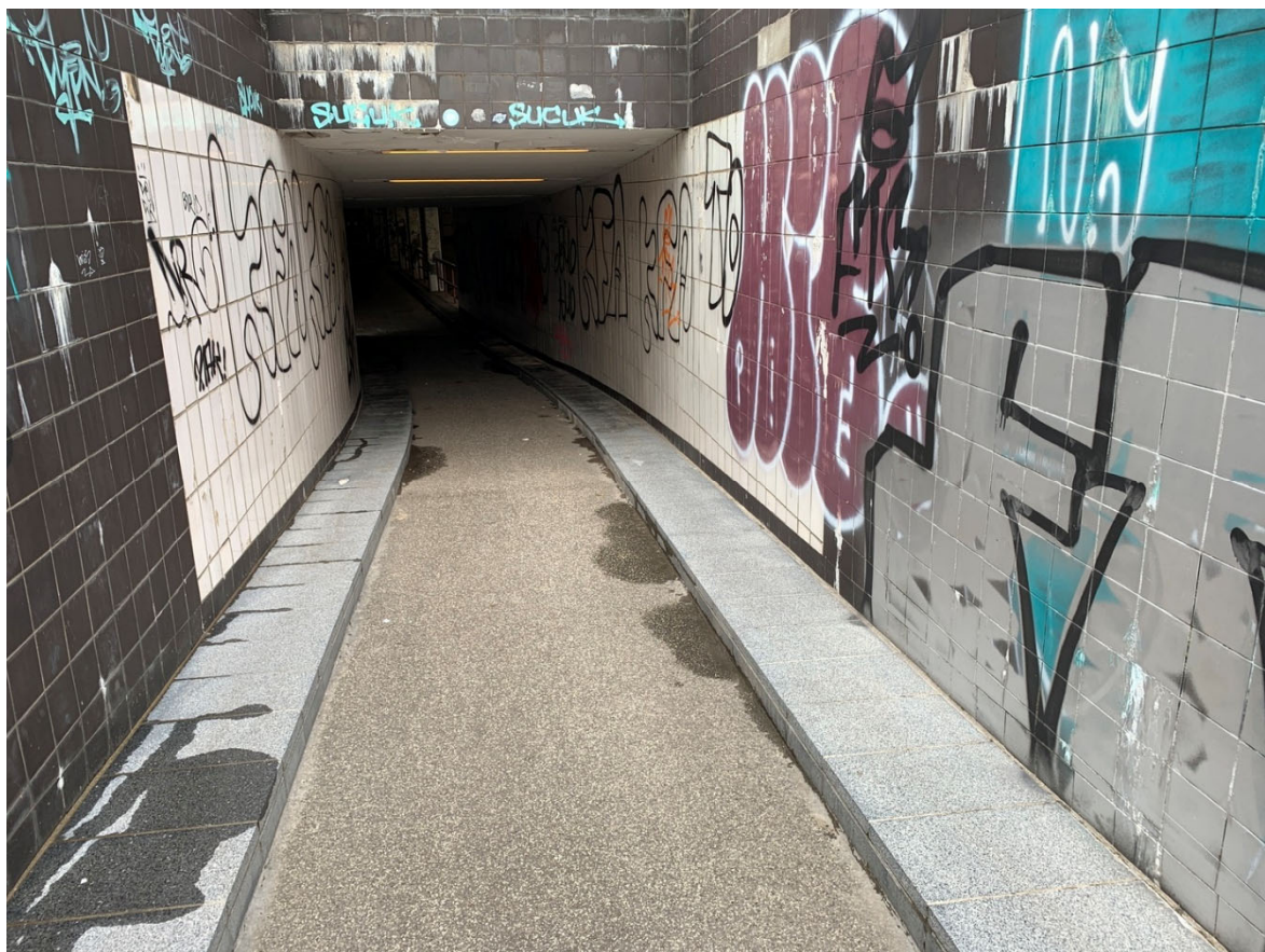
Zugang Markhalle: Fahrradrampe
