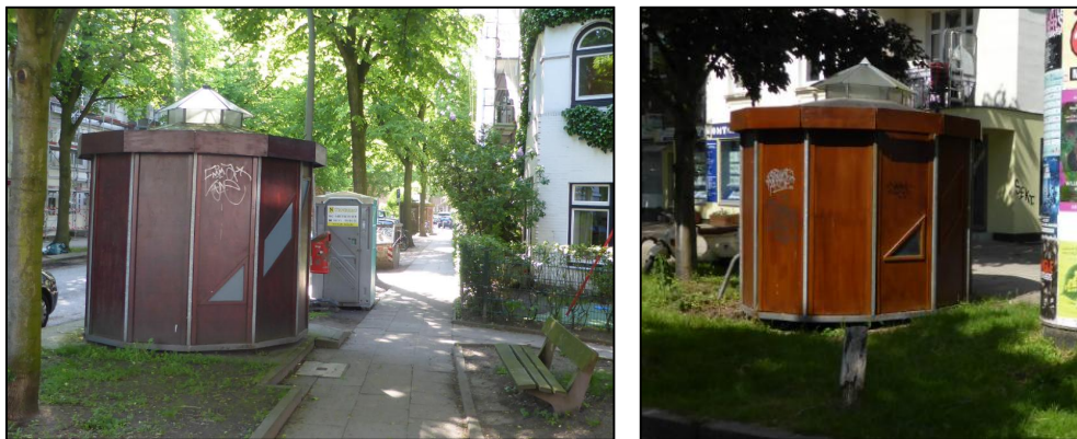
Abb. 2.27 Fahrradhäuschen in der Straße „Imstedt“ und Mozartstraße (Quelle: Sweco GmbH)
