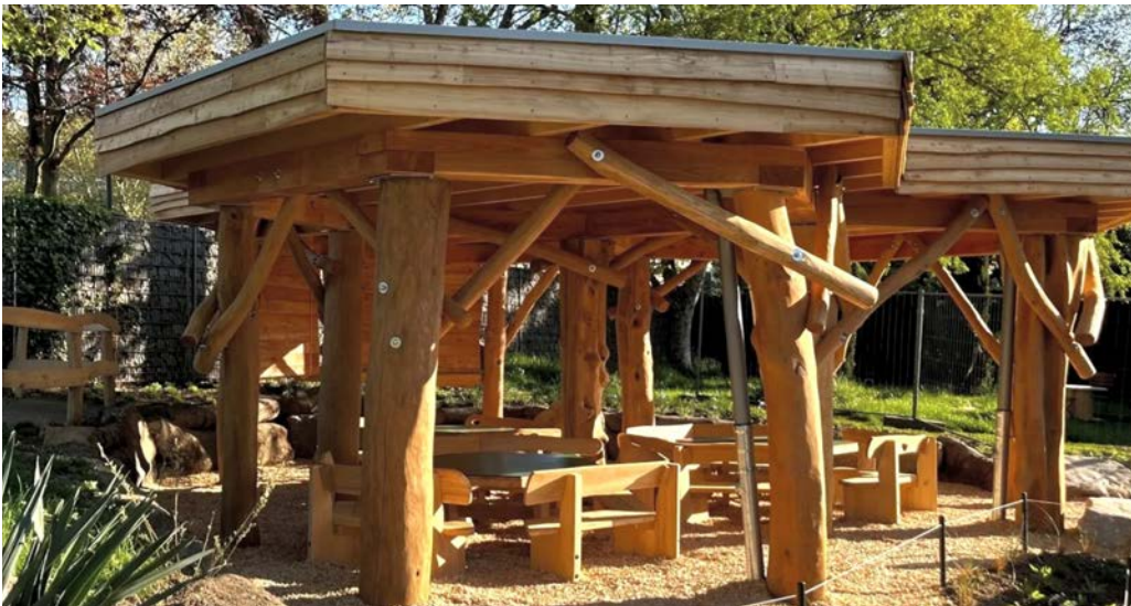
Beispiel für Tragwerk aus Robinienholzstämmen
