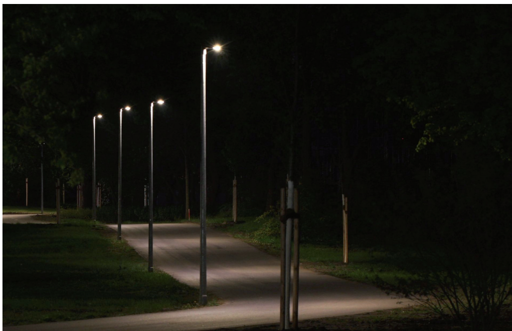
Bild 5 LED-Wegeleuchte mit geringer Umfeldaufhellung
