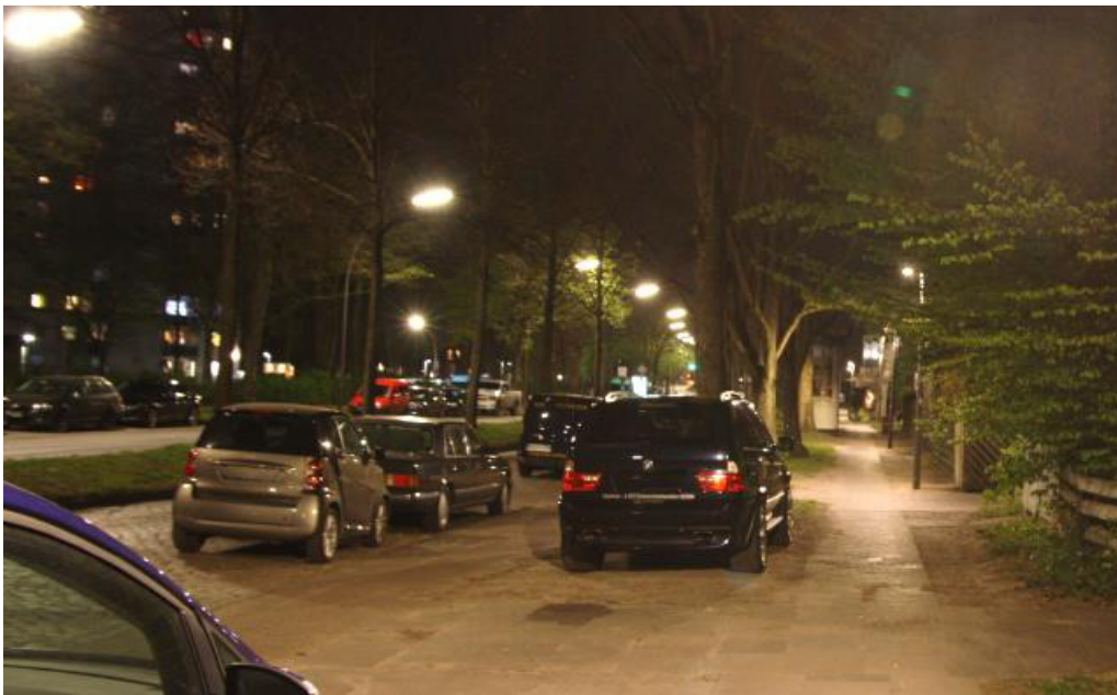
Bild 7 Friedensallee, abgelegener Gehweg mit neuer Beleuchtung
