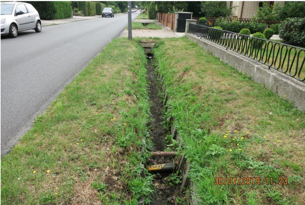
Vorh. Graben teilverbaut - Sichtrichtung Süd mit kreuzenden HA-Leitungen (Quelle: wfw nord consult)
