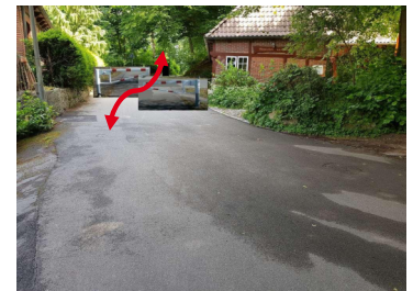
Bild 15: Nördlicher Anschluss – 6. Absperrvariante (Quelle: Eigene Aufnahme 2017, bearbeitet)
