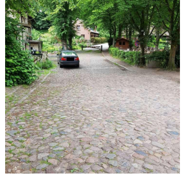
Abbildung 2: Bestand - Alte Mühle (Quelle: Eigene Aufnahme 2021)
