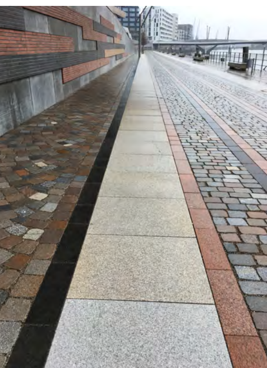
Plattenstreifen aus Granit
