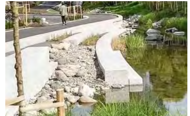
Sitzstufen und Kiesschüttung
