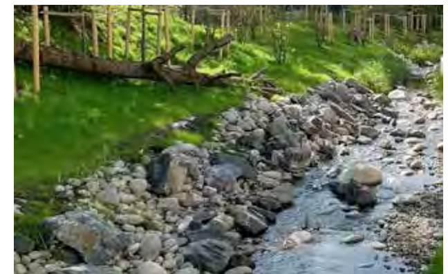
Kiesschüttungen und ,Trittsteine' als Querungshilfe
