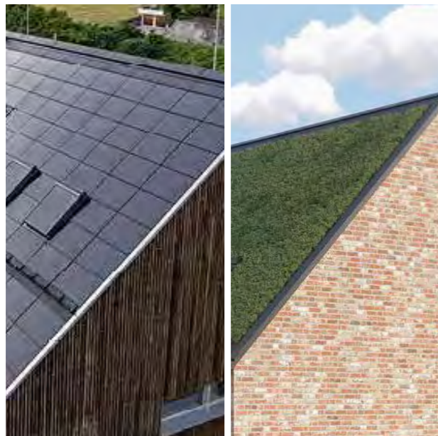
Skulpturales Dach mit PV Paneelen (Süd) und extensiver Begrünung (Nord) G1-G3: Wohnhäuser
