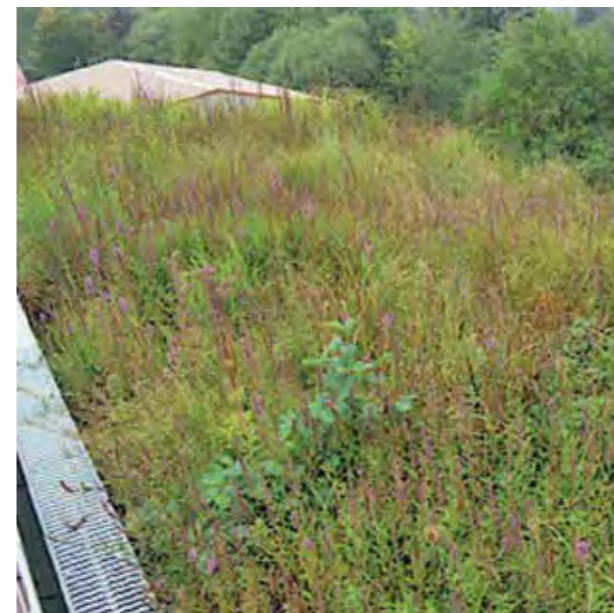
intensives Biodiversitätsdach: G6 (Markthalle) mit öffentlichem Weg
