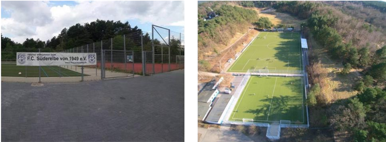
Abb. 27: Modernisierung und Erweiterung des Sportplatzes am Kiesberg (Quelle: FC Süderelbe)
