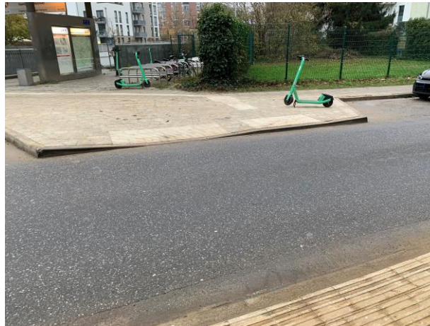
Baulich hergestellte Querungshilfe Upn Hornack; FHH, BA Eimsbüttel
