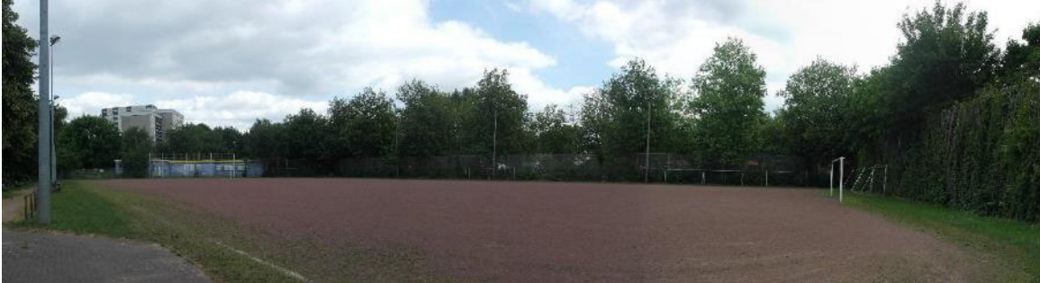
Abb. 27: Sanierungsbedürftige Sportanlage Friedrich-Frank-Bogen
