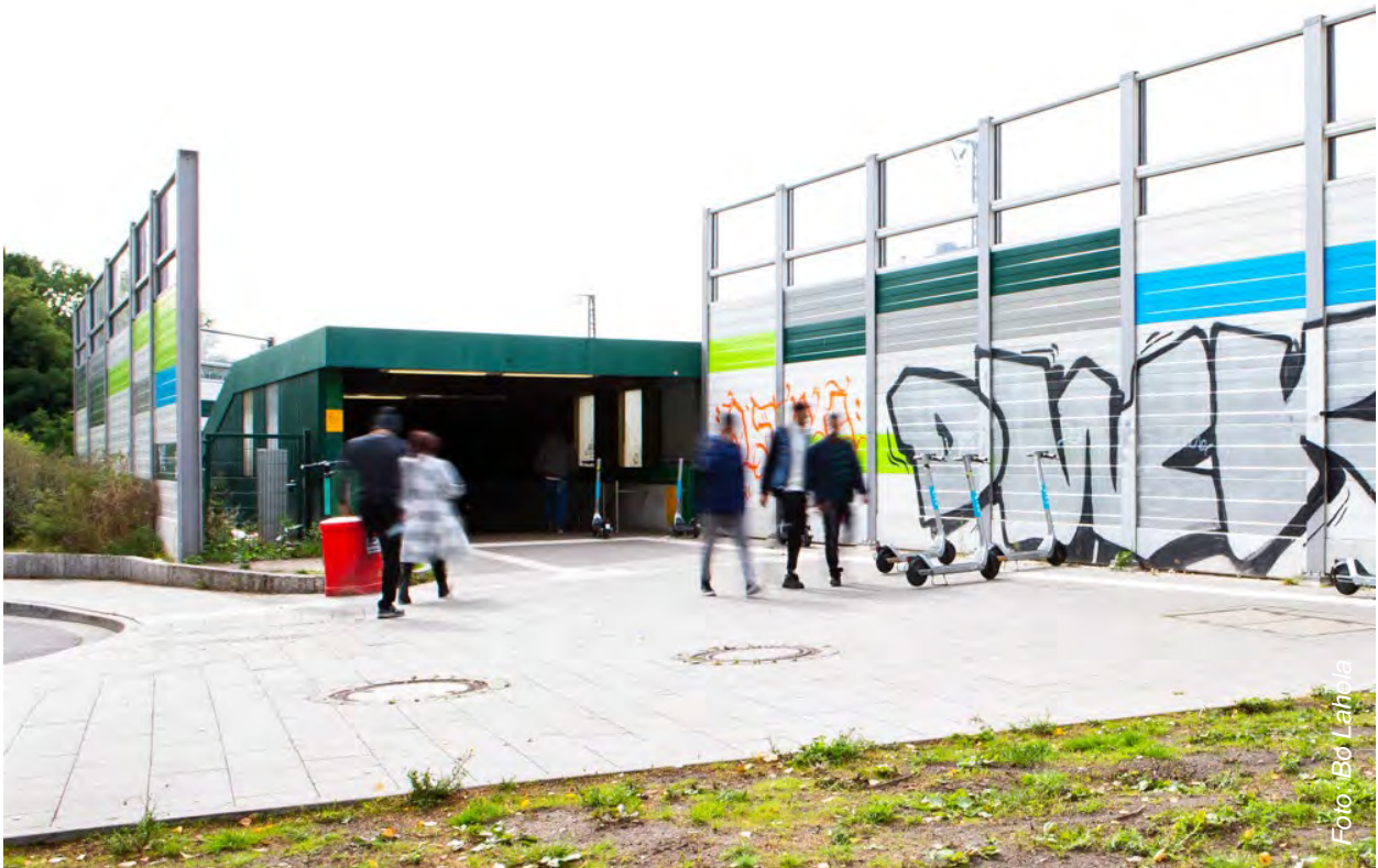
Abb. 20 S-Bahnstation Wilhelmsburg mit Lärmschutzwand, Foto © Fachamt Stadt- und Landschaftsplanung
