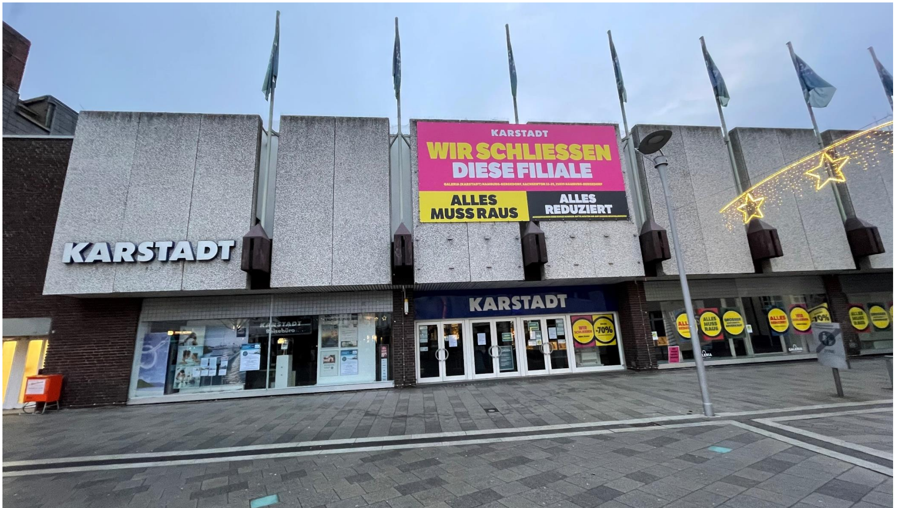
BLICK AUF DEN EHEMALIGEN KARSTADT AM BERGEDORFER MARKT
