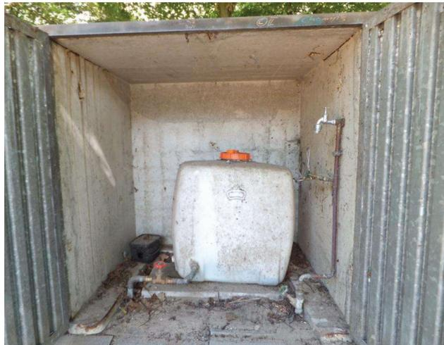
Container + Wasserbehälter der Pos. 4.1.110 mit Druckwasserleitung (rechts) und Pumpenzuleitung (links)
