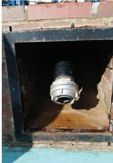
Beckeneinspeisung mit Feuerwehrrkupplung
