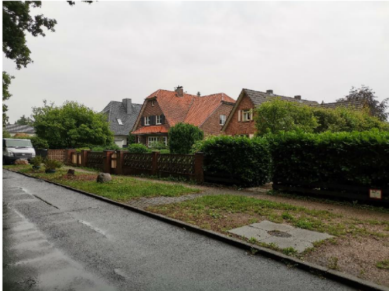
Bild 5: Nebenanlagen im Bereich der Haus Nrn. 3 – 9
