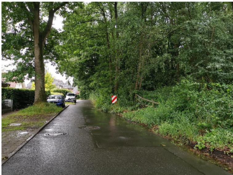
Bild 6: Fahrbahnreduzierung im Bereich Haus Nr. 15
