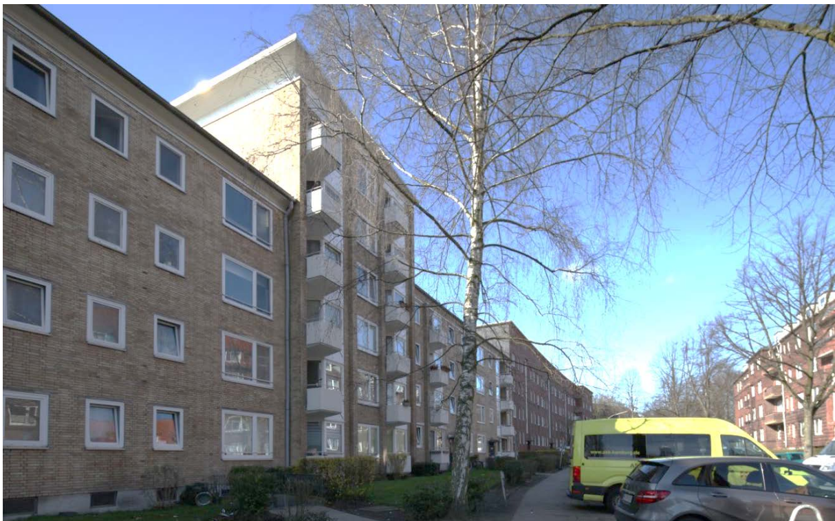
Abb. 37 Selten gewordenes Beispiel für ungestörten Siedlungsbau in „geelschem“ Klinker in der O'Swaldstraße Ecke Bauerberg (2. BA) (Sprotte und Neve, 1953-55)
