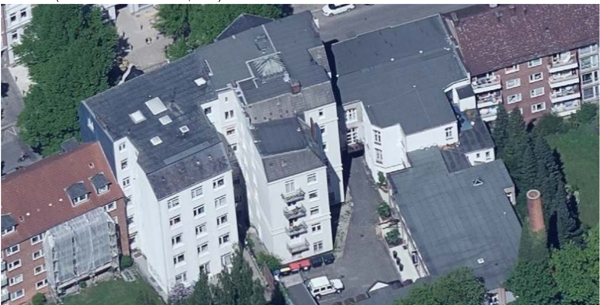
Abb. 25 Reste Hamburger Schlitzbebauung an der Hasselbrookstraße (Schrägluftaufnahme© FHH, LGV)
