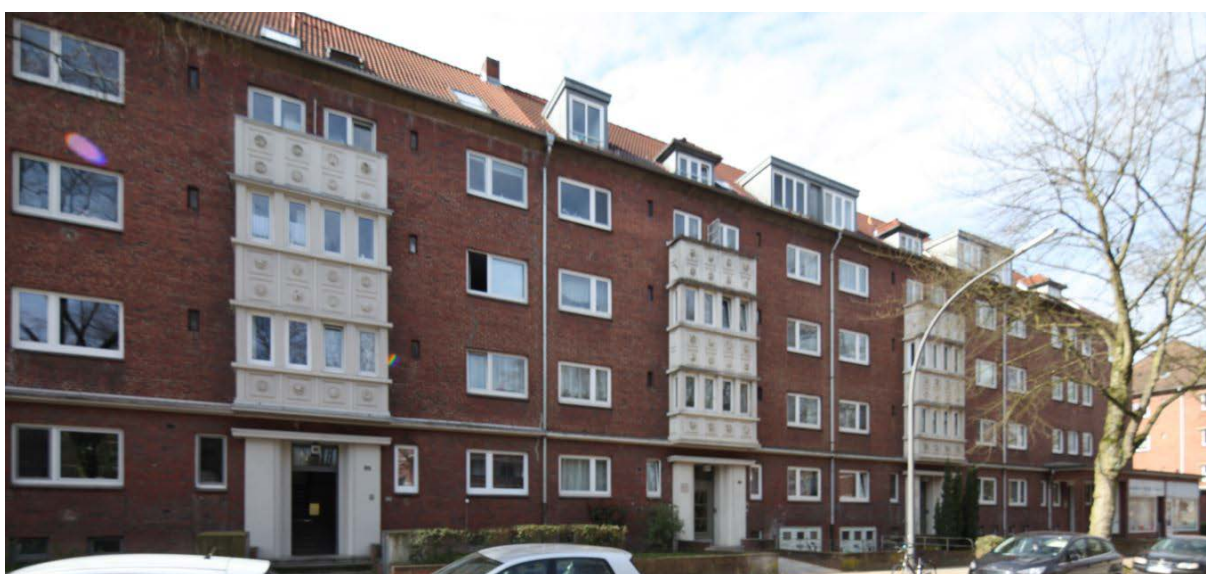
Abb. 42 Siedlungsbau an der Washingtonallee (Hans Stockhausen 1936-37)
