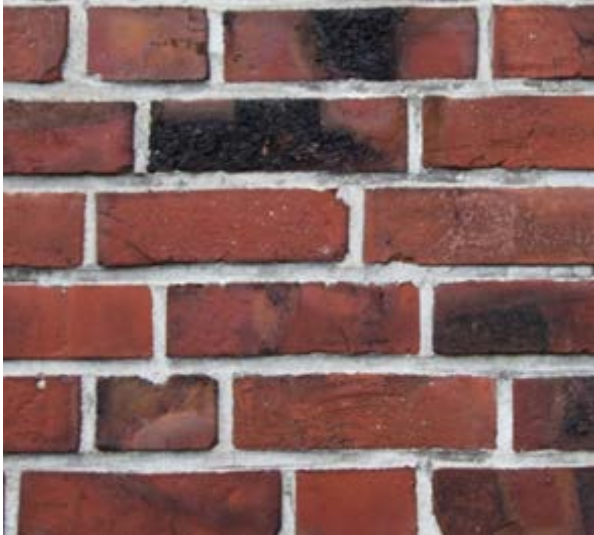
Abb. 32 typischer Backstein i, Wiederaufbau mit Kohlebrandzeichnung und weißem Fugennetz in Wildem Verband
