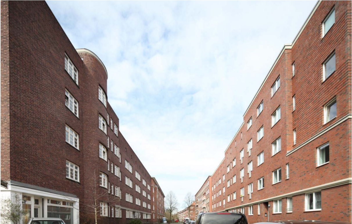
Abb. 50 Viergeschossige blockrandbildende Bebauung der Zwischenkriegszeit im Grosseweg ... (links: Hans Stockhause, 1930 - 31, rechts: Dorendorf-Architekten, 1931, Wärmedämmung 2012 )
