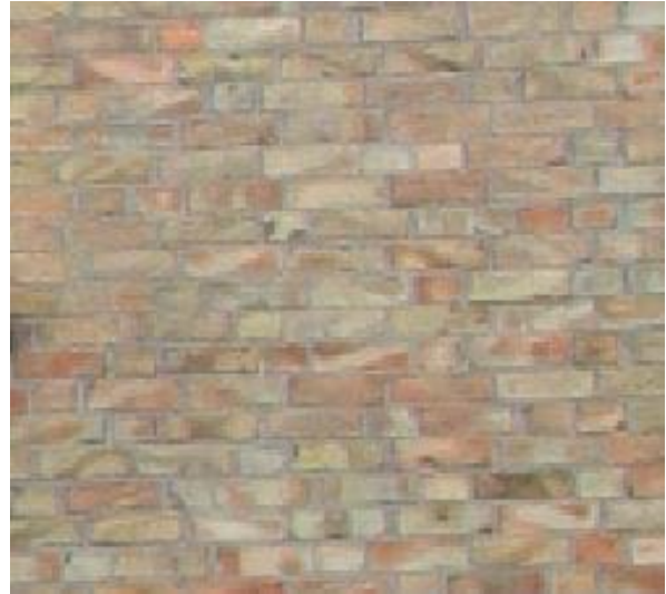
Abb. 33 Gelber Backstein mit Kohlebrandanteilen, farbigen Zuschlägen und grauen Fugen in Wildem Verband
