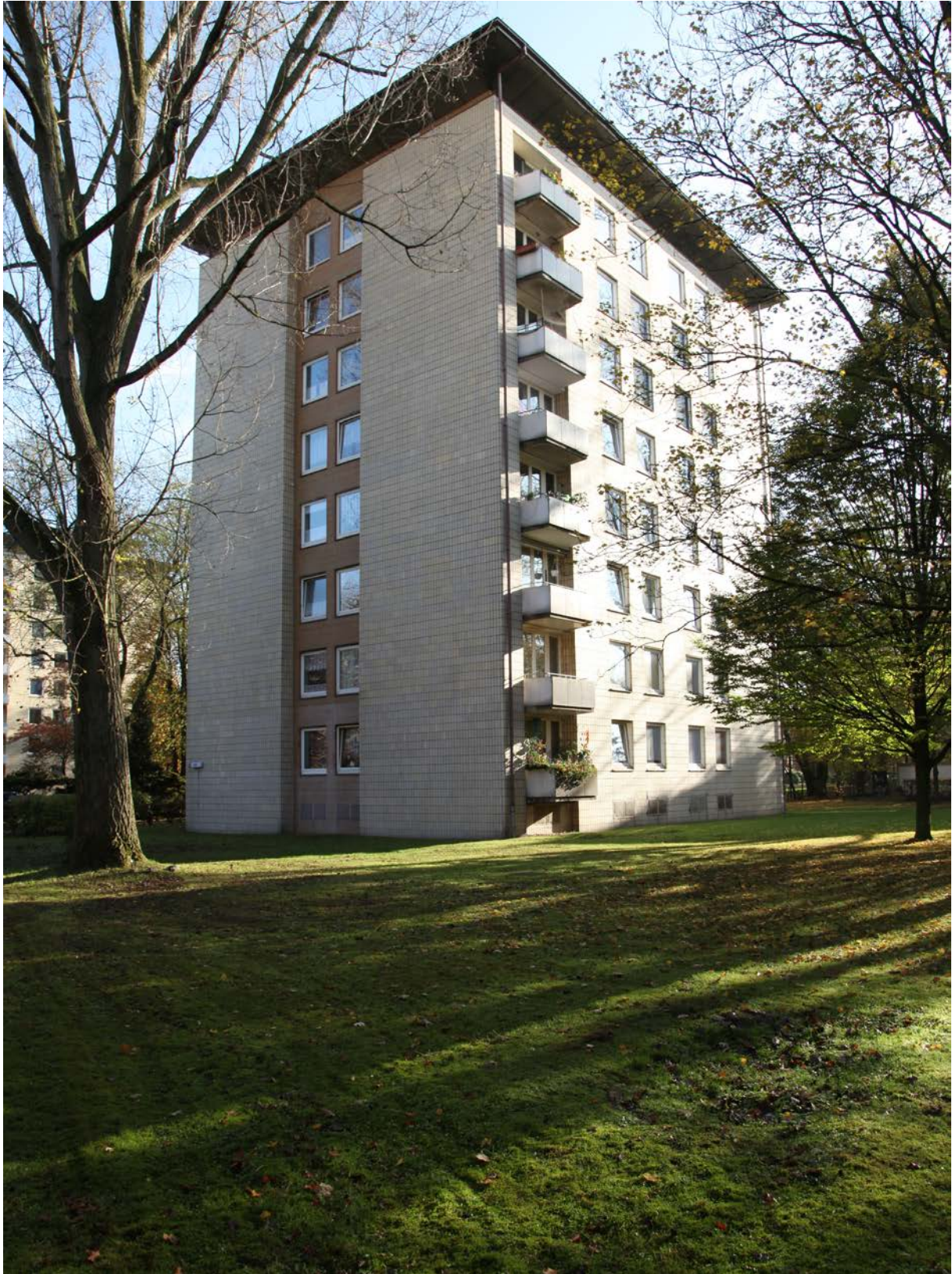
Abb. 55 Punkthochhaus am Rhiemsweg noch im gelben Fliesenkleid in analog zur Höhe aufgeweitetem „Fließendem Grünraum“, der mit raumbildenden Großgehölzen gegliedert ist (Entwurf: Heinz Dorendorf, 1957 - 60)
