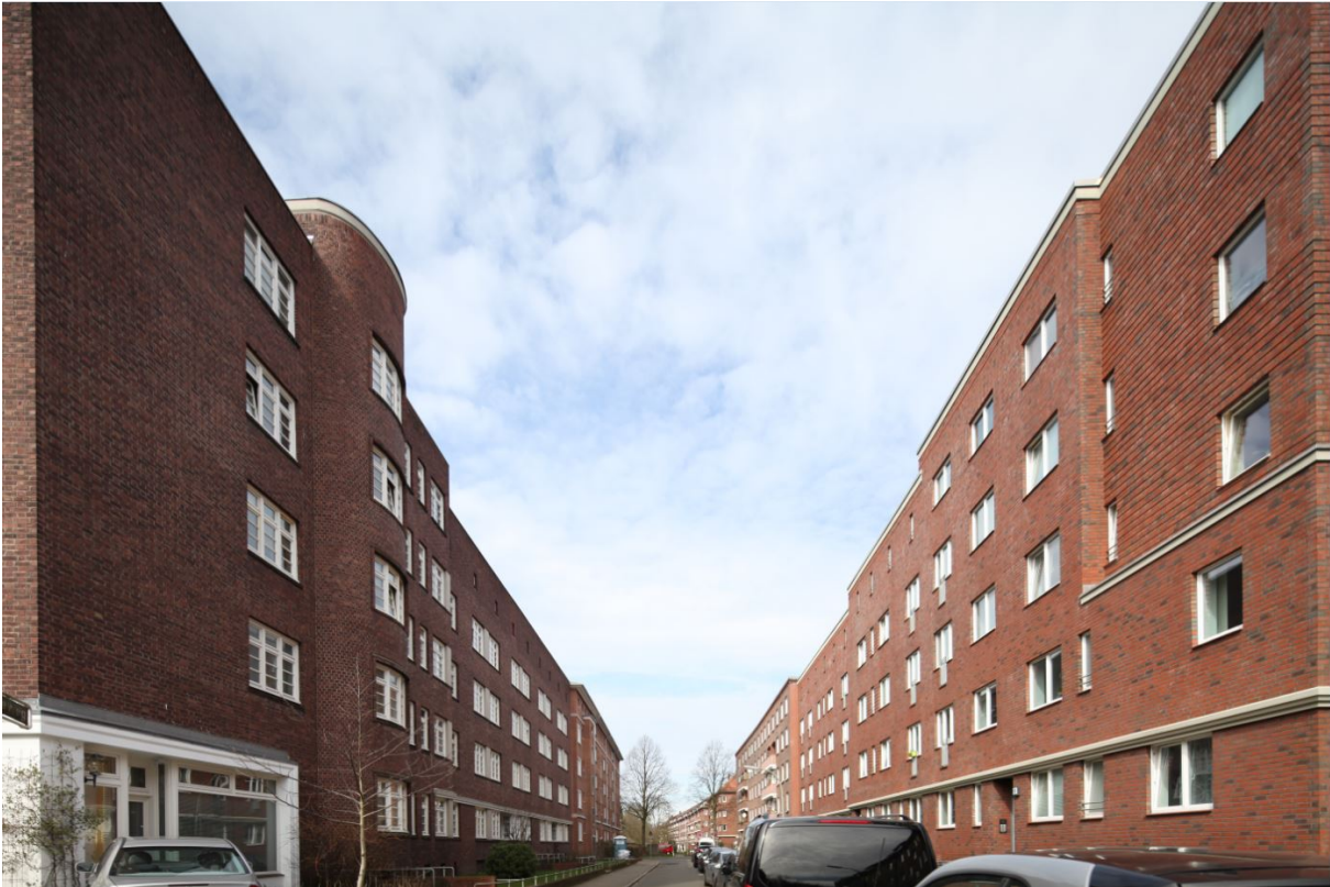
Abb. 45 Neue Sachlichkeit: Bebauung der Zwischenkriegszeit im Grosseweg (links im Originalzustand, rechts überdämmt)
