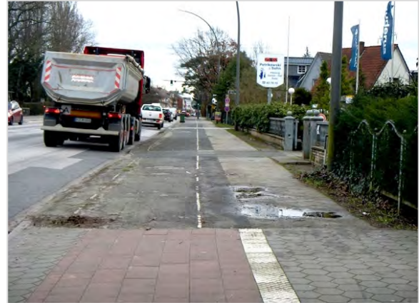
Abb. 58 Beeinträchtigungen durch Unebenheit des Pflasters verbunden mit Pfützenbildung sowie Verkehr (Bereich Luruper Hauptstraße 279 - 281)
