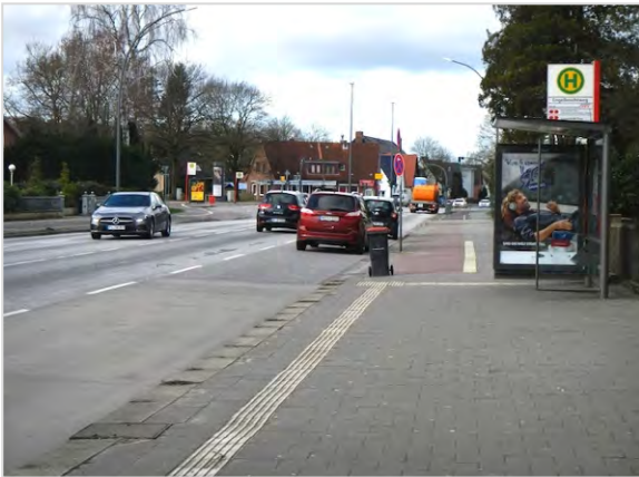
Abb. 63 Unterbrochener Fahrradweg an der Haltestelle Engelbrechtweg, hinten ein kurzes Teilstück mit Leitstreifen
