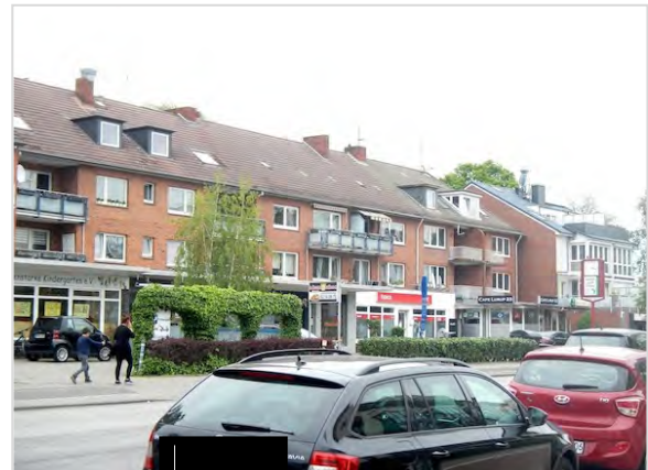
Abb. 5 Dreigeschossiger Wohnungsbau aus den 1960er Jahren (Luruper Hauptstraße 250-256).
