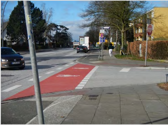
Abb. 61 Radweg-Markierung am Überweg Fahrenort
