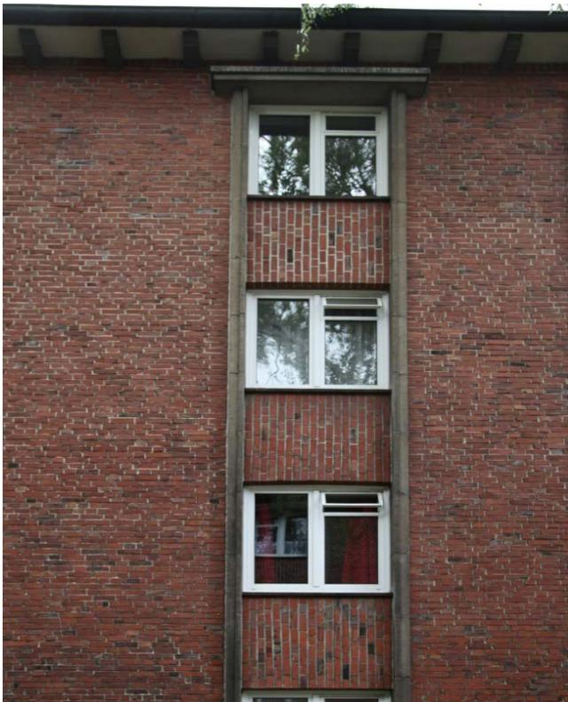
Abb. 28 Schmuckverband in Werksteinfassung an Giebelfront unter verschaltem Dachüberstand mit sichtigen Balkenköpfen
