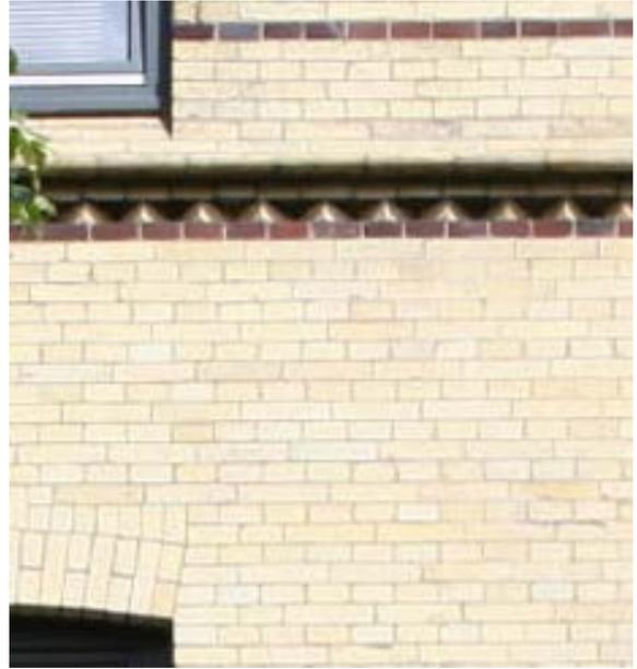
Abb. 27 gelbe Backsteinfassade des gründerzeitlichen Mathiasstift im Kreuzverband mit Pressfugen und bandförmigen Zierverbänden
