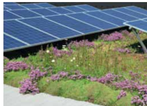
Photovoltaik-Gründach: G4 Ost (Gewerbe)
