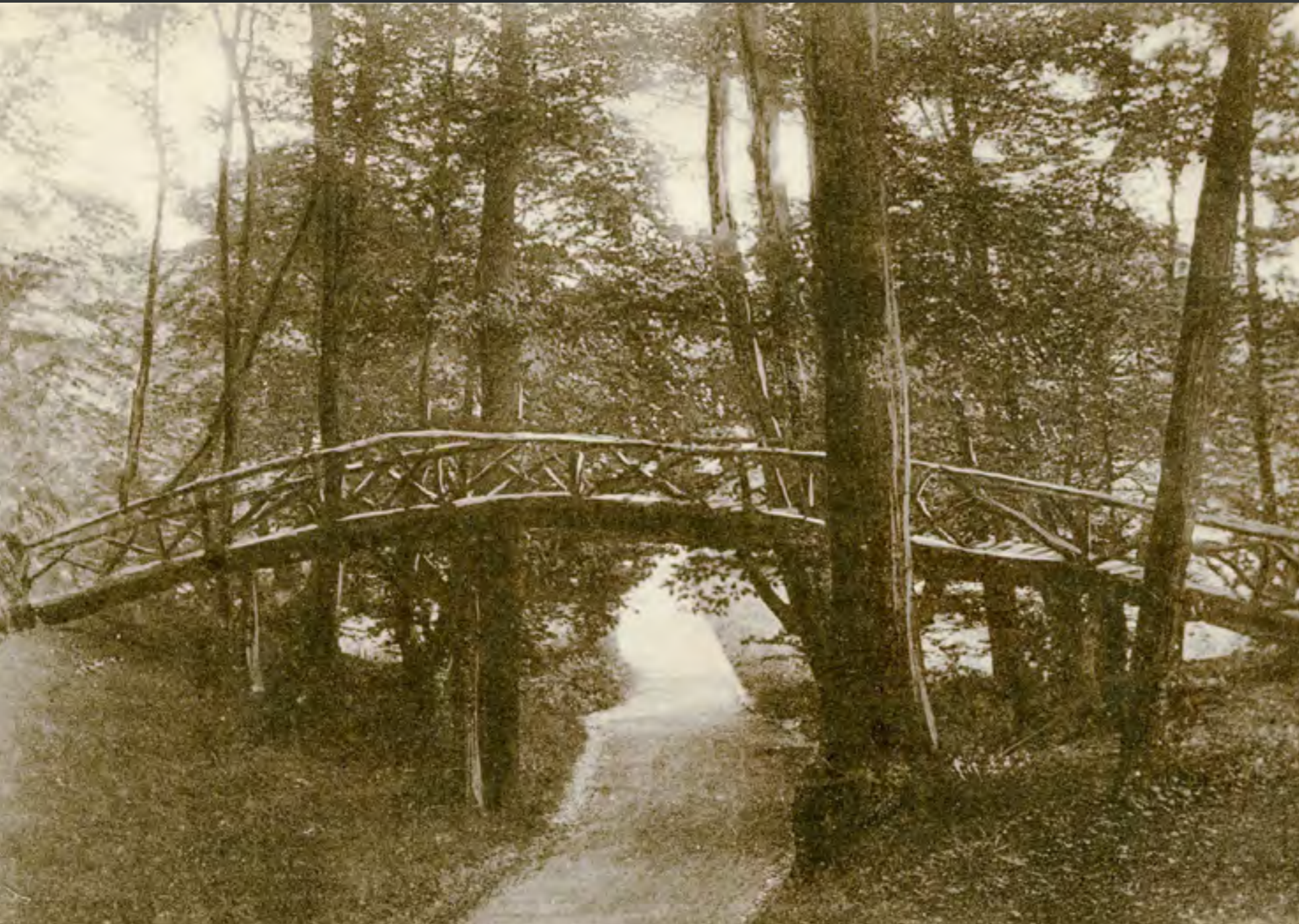
Knüppelbrücke, E. Ehmling, 1933
