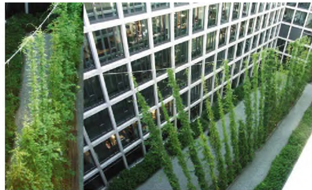
Beispiel Innenhofbegrünung: Westpark Zürich, Raderschall Landschaftsarchitekten
