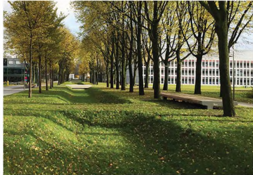
Retentionsmulden im Kluver-Park von Karres en Brands
