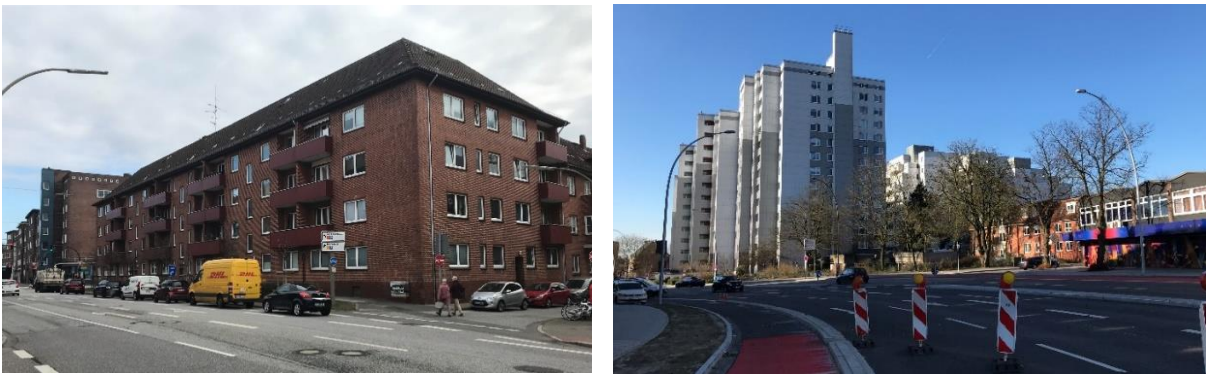
Abb. 10 und Abb. 11: Wohngebäude Vierlandenstraße, Sander Damm Lohbrügge (Bilder: steg Hamburg)
