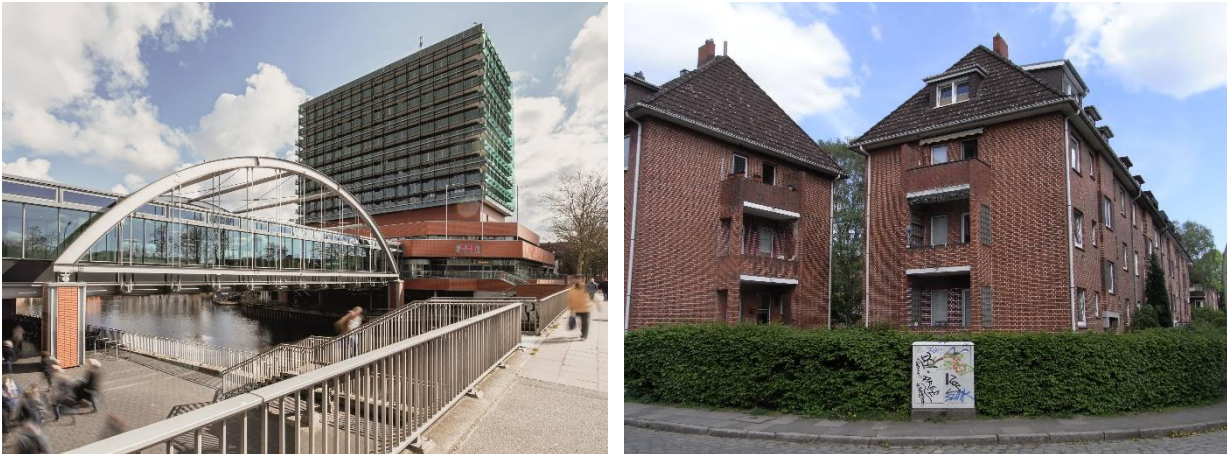
Abb. 2 und Abb. 3: „Wohnturm“ des CCB sowie Wohnbebauung Am Hohen Stege (Bilder: Walter Schießwohl/steg Hamburg)
