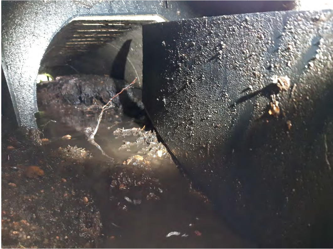
Foto 5: Tunneleingang am Klövensteenweg
