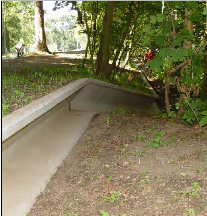
Abb. 3.2.1: Lungauer Betonsegmente des Herstellers Zieger; Quelle: http://www.zieger-amphibienschutz.com/Produkte/dauerhafter-Schutz/Lungauer/lungauer.html
