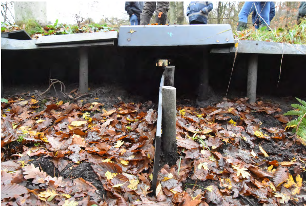
Foto 4: Tunneleingang am Klövensteinweg
