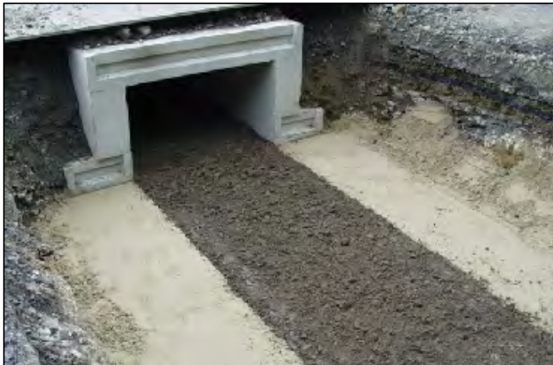
Abb. 3.1: Stelztunnelsegment des Herstellers Zieger; Quelle: http://www.zieger-amphibienschutz.com/Produkte/dauerhafter-Schutz/Stelztunnel/stelztunnel.html
