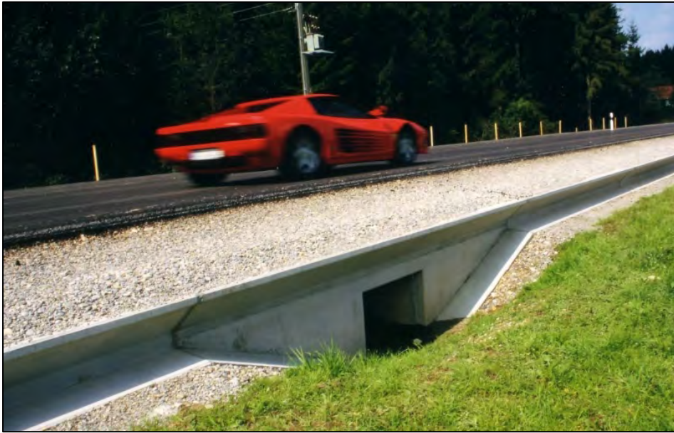
Abb. 3.2.2: Tunnel Ein- und Ausgangssegment des Herstellers Zieger Quelle: http://www.zieger-amphibienschutz.com/Produkte/dauerhafter-Schutz/Tunnel-Ein--Ausgangssegment/tunnel-ein--ausgangssegment.html
