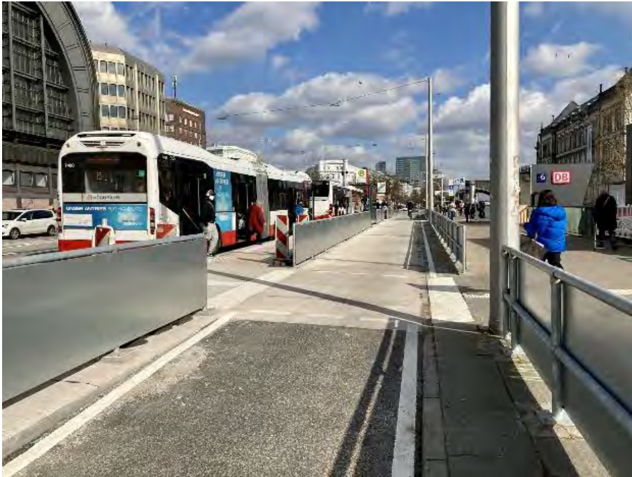
Bild 21: Radverkehrsführung an der Bushaltestelle Hauptbahnhof / Steintorbrücke. © BVM
