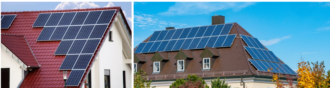
Abb. 3: PV-Anlage installiert mit Abstand zur Dachgaube (links) und oberhalb von Dachgauben (rechts) zur Vermeidung von übermäßigen Verschattungsverlusten (Quelle: © U.J.Alexander, stock.adobe.com, © Animaflora PicsStock, stock.adobe.com)
