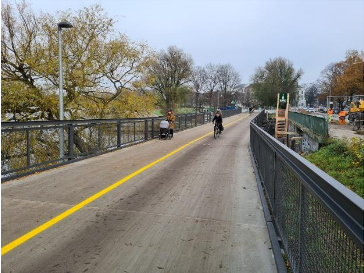
Bild 21: Behelfsbrücke Hohenfelder Bucht. © BVM
