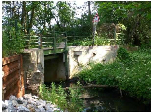
Abbildung 3-12: Brücke Wandseredder mit behelfsmäßigen Befestigungsmaßnahmen (Spundwand und Steinschüttung) im Vordergrund (in Fließrichtung, Juni 2019)
