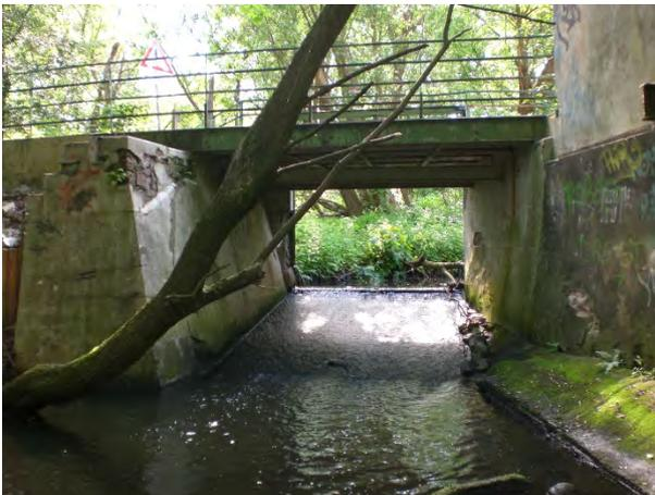
Abbildung 3-7: Ökologisch nicht durchgängige Sohlrampe im Brückenbereich (gegen Fließrichtung, Juni 2019)
