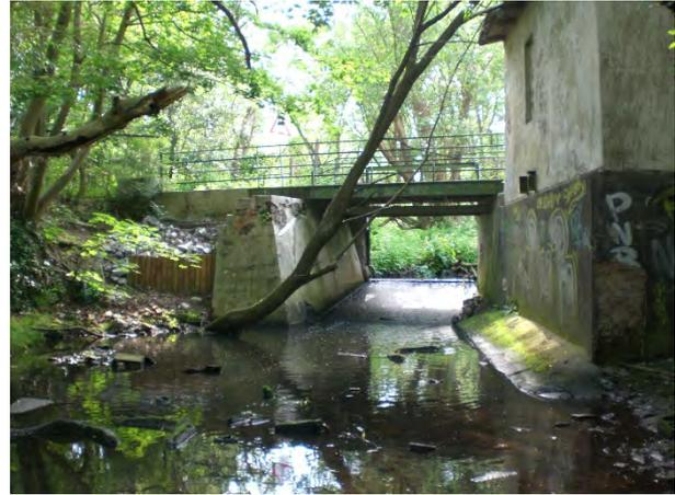
Abbildung 3-14: Brücke Wandseredder mit behelfsmäßigen Befestigungsmaßnahmen links (Palisaden mit dahinterliegender Steinschüttung) sowie der Lackfabrik rechts (gegen Fließrichtung, Juni 2019)
