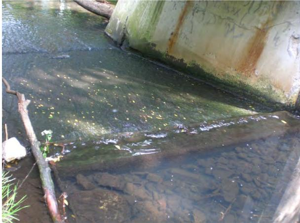
Abbildung 3-13: Ökologisch nicht durchgängige Sohlrampe im Brückenbereich (in Fließrichtung, Juni 2019)
