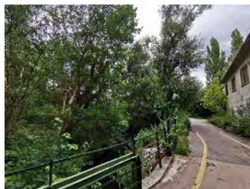
Abbildung 7: Brücke Wandserredder, Blick nach Süden
