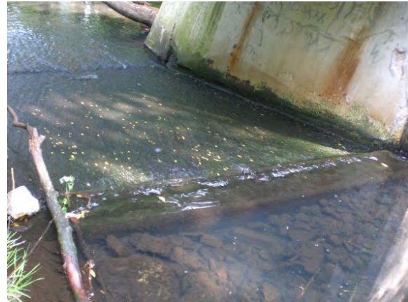
Abbildung 11: Sohlrampe unterhalb der Brücke
