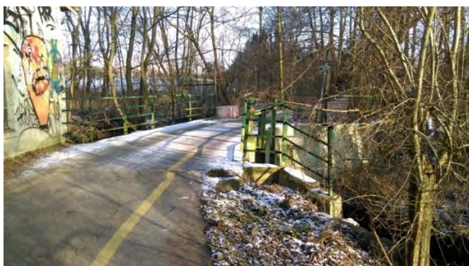
Abbildung 6: Brücke Wandserredder, Blick nach Norden
