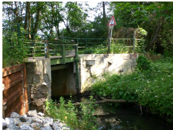
Abbildung 5: Ostseite der Brücke Wandserredder
