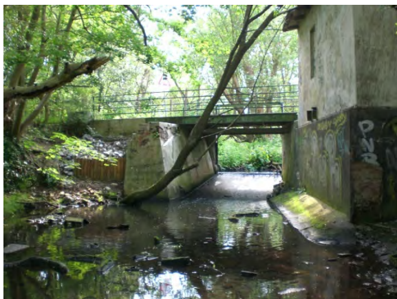
Abbildung 4: Westseite der Brücke Wandserredder
