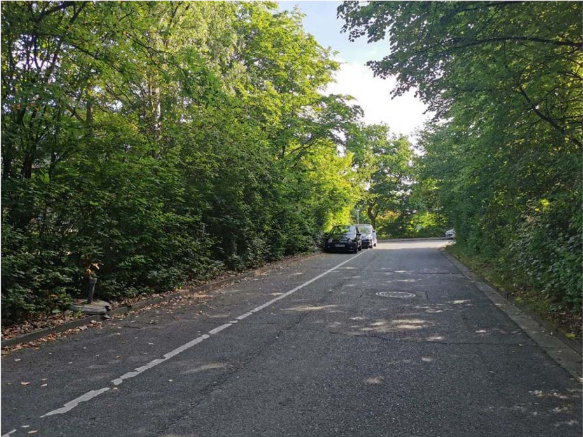
Abbildung 3: Erster Abschnitt der Erschließungsstraße (Quelle: ARGUS)
