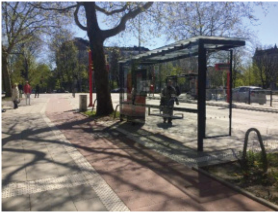
Radwegführung hinter einer Bushaltestelle an der Mundsburger Brücke in Hamburg
