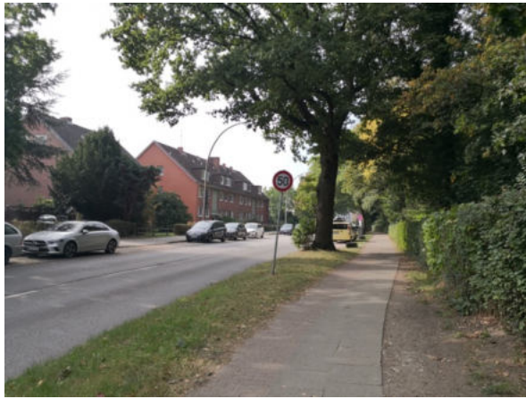
Die Straße Rungwisch hat eine zulässige Höchstgeschwindigkeit von 50 km/h. Der Seitenraum weist eine Breite von 1 bis 1,5 m auf.
