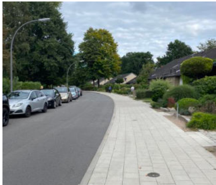
Instandgesetzter Seitenraum am Torfweg
