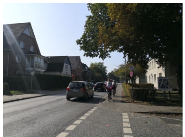
Die Elbgaustraße als wichtige Wegeverbindung verfügt über einen 1,5 m breiten Seitenraum für Fuß- und Radverkehr im Abschnitt zwischen Elbgaustaße Nr. 80 und Redingskamp.
