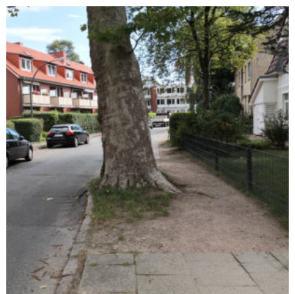
Wassergebundene Deckschicht um einen Straßenbaum (Hinschstraße)
