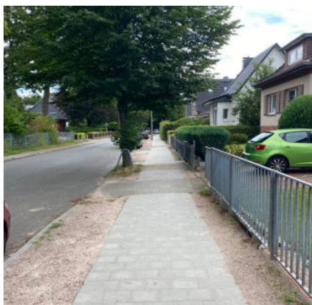
Neu instandgesetzter Fußweg mit ungepflasterten Seitenflächen
