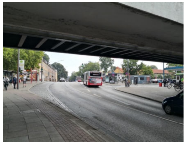
Unter den Gleisen ist der Seitenraum schmal: 1,5 m breiter Gehweg und 1 m breiter Radweg ohne Sicherheitstrennstreifen.
