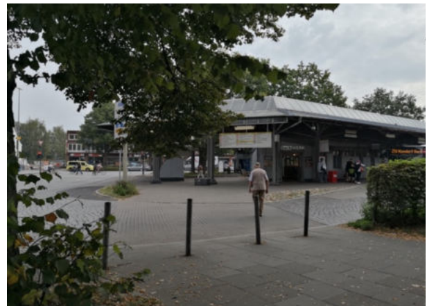
Querungsbereich zum Busbahnhof ist nicht barrierefrei gestaltet
