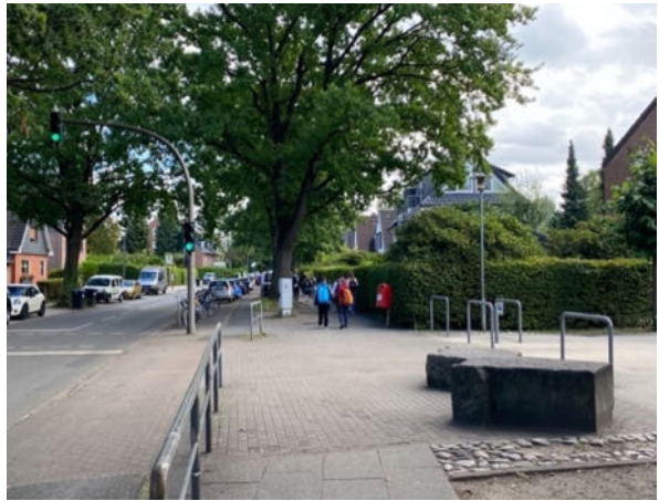
Nicht barrierefreie Querungsanlage. Allerdings ist vor dem Schuleingang ausreichend Platz.
