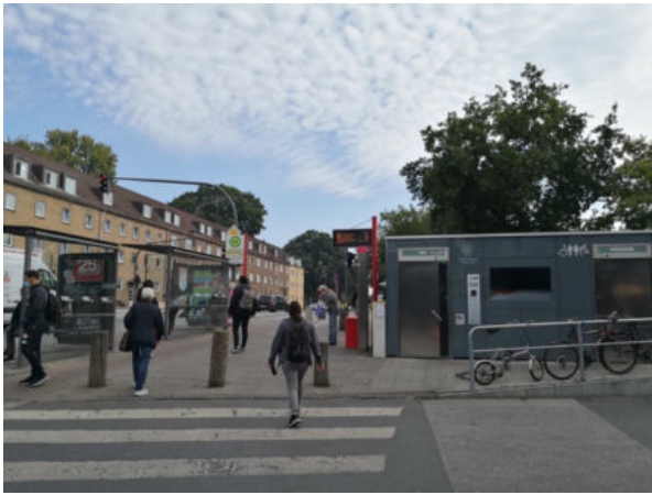
Nicht barrierefreie Querungsanlage und geringe Aufenthaltsqualität an der S-Bahn-Station.
