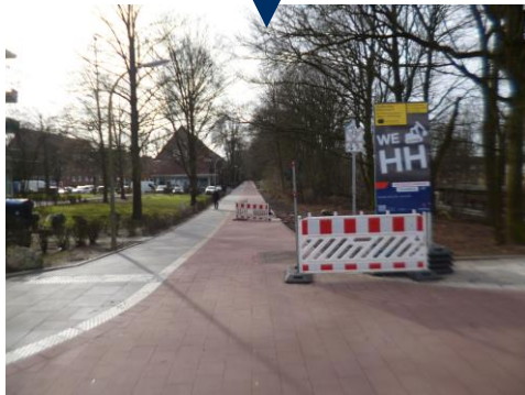
Baufortschritt Veloroute 4 - Am Ohlmoorgraben
