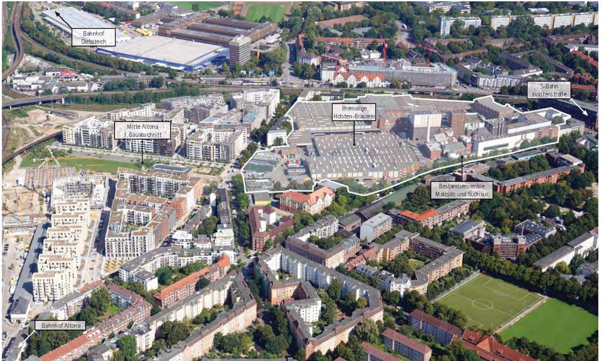
Luftfoto Bestand Holsten Areal und Umfeld
