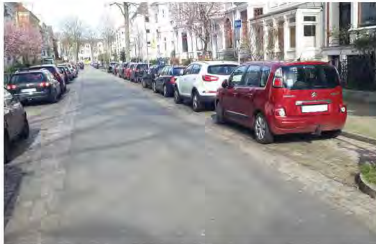
Pflaster in Bereich PKW- und Fahrradstellplätzen Beispiel Bremen
