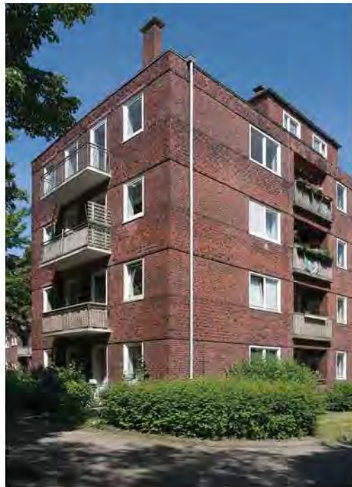
Gustav Oelsner | Siedlungsbauensemble Arnisstraße, Hamburg
