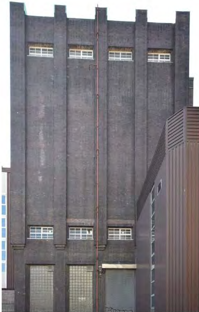
Das Malzsilo/ Neues Sudhaus
