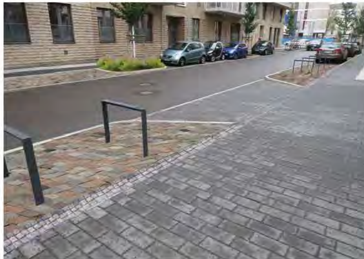
Pflaster in Bereich PKW- und Fahrradstellplätzen
