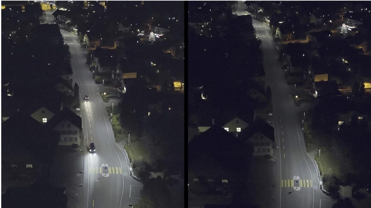
Abb. A1. Bedarfsgerechte Beleuchtung in der Schweiz (Urdorf). Bei geringem Verkehrsaufkommen wird die Beleuchtungsstärke von 100% (links) auf 40% (rechts) reduziert. Foto: Elektrizitätswerke des Kantons Zürich (EKZ)
