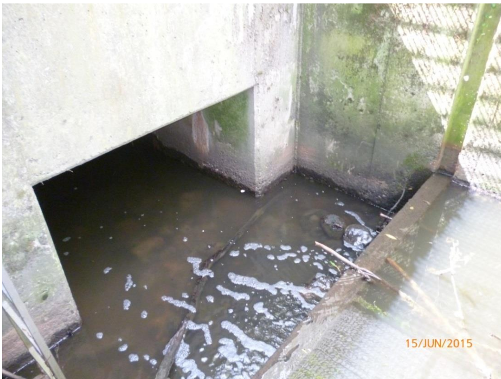
Abb. 10: Wehr mit anschließenden Durchlass HRB Blakshörn
