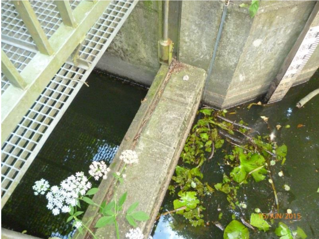
Abb. 6: Unterströmtes Schütz HRB Sasel
