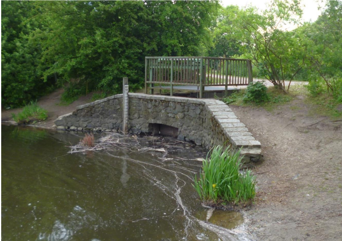
Abb. 9: Absperrbauwerks HRB Blakshörn im Juni 2015
