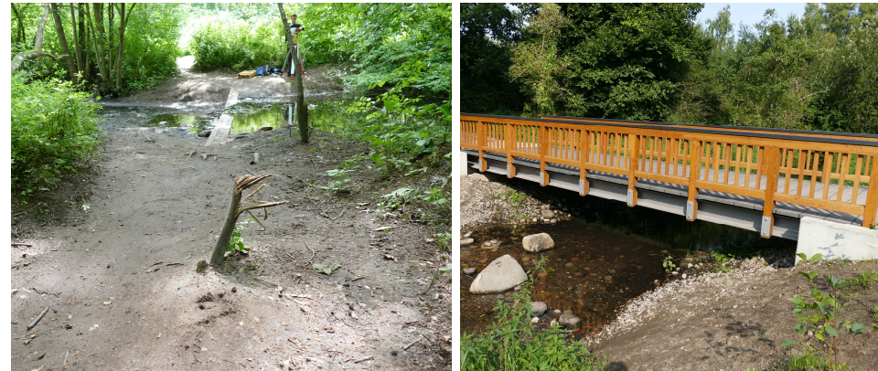
Foto: MR 31, Querungsbereich des Sees und Brück 11/ 2021
