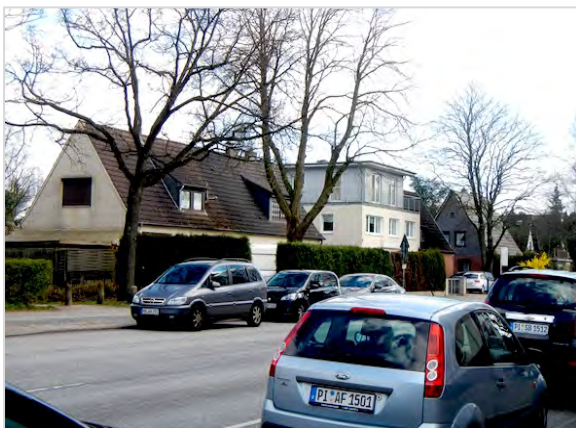
Abb. 21 Aufstockung Haus Luruper Hauptstraße 240
