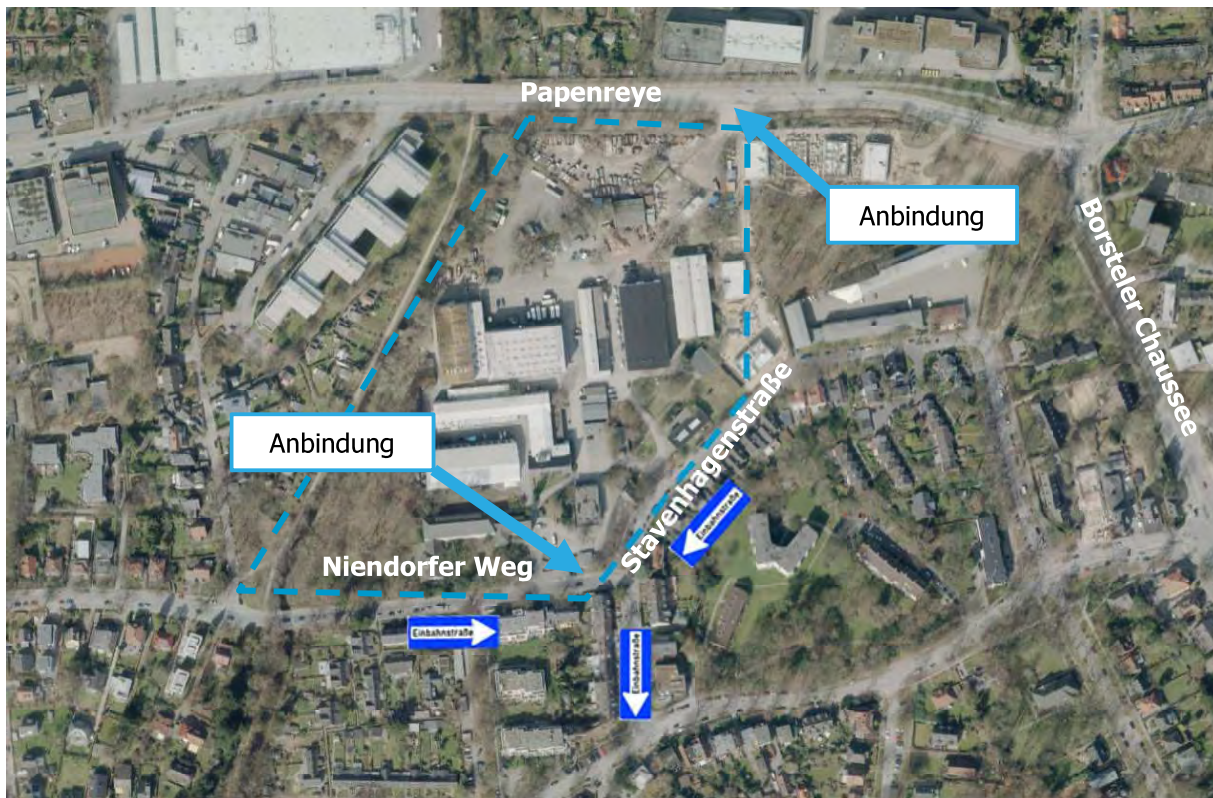
Abbildung 2: Luftbild der Bestandssituation
