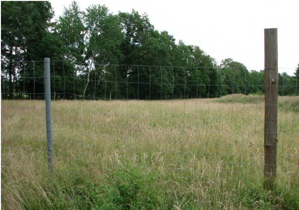
Illustration 22: Holzstützen werden durch haltbarere Recyclingkunststoffstützen ersetzt
