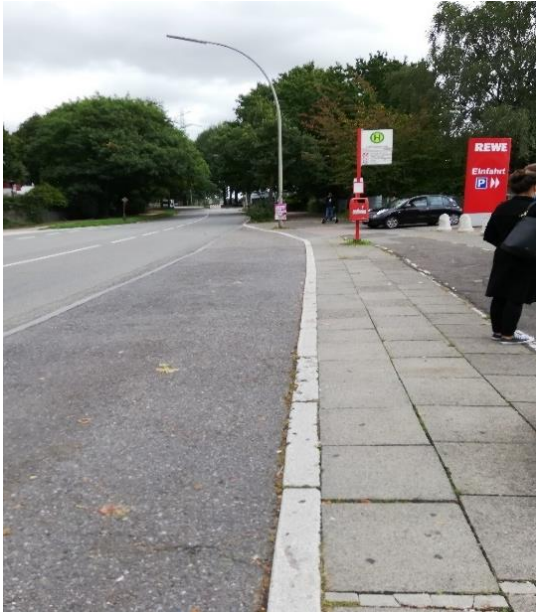
Abb. 12: zu stark abgesenkter Bordstein
