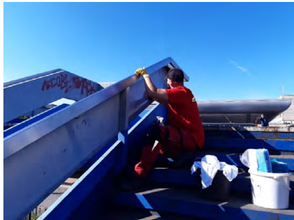
Abb. 22: Eine Fremdfirma bei der Entfernung der Graffitis und bei der Entfernung von Plakatresten (Foto © plankontor)
