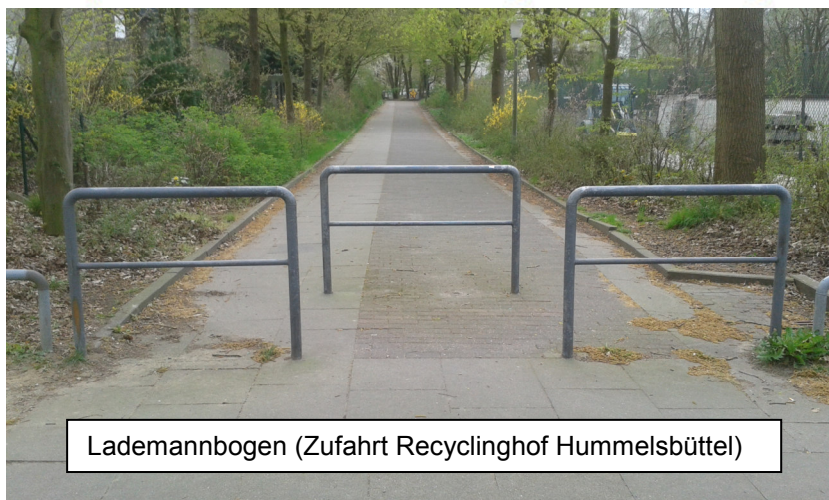
Diese Umlaufsperrre wurde zusammen mit der Fahrradabstellanlage S-Hoheneichen (im Hintergrund sichtbar) erstellt und verhindert erfolgreich die Durchfahrt mit Anhänger oder Kinderwagen.
