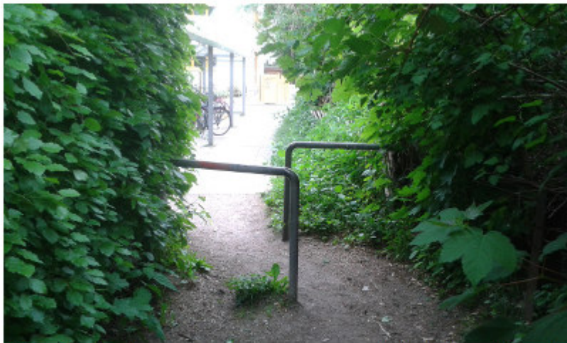
Diese Umlaufsperrre wurde zusammen mit der Fahrradabstellanlage S-Hoheneichen (im Hintergrund sichtbar) erstellt und verhindert erfolgreich die Durchfahrt mit Anhänger oder Kinderwagen.
