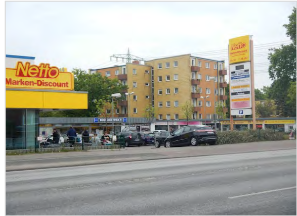
Abb. 7 Ladenzentrum mit mehrgeschossigem Wohnungsbau aus den 1960er Jahren im Hintergrund.
