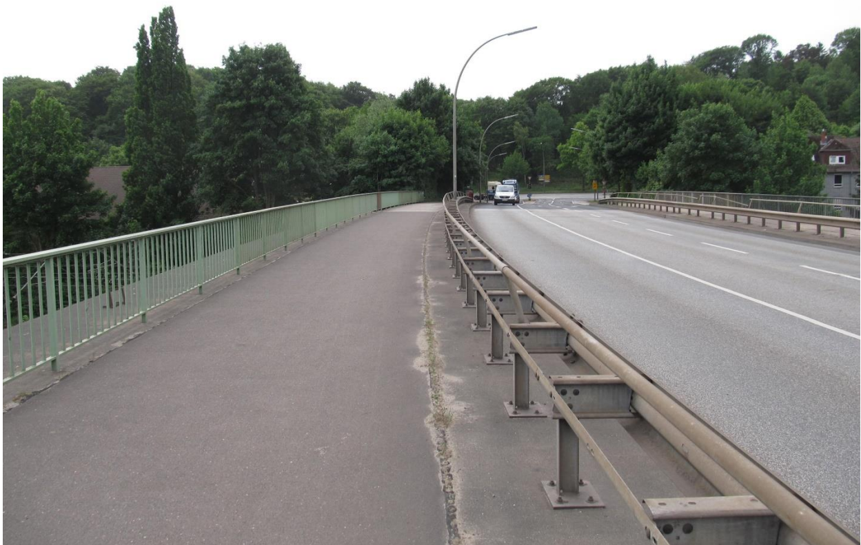
Abbildung 3: Beispielfoto Brückenbauwerk 669 (Waltershofer Straße, Blickrichtung Süden)
