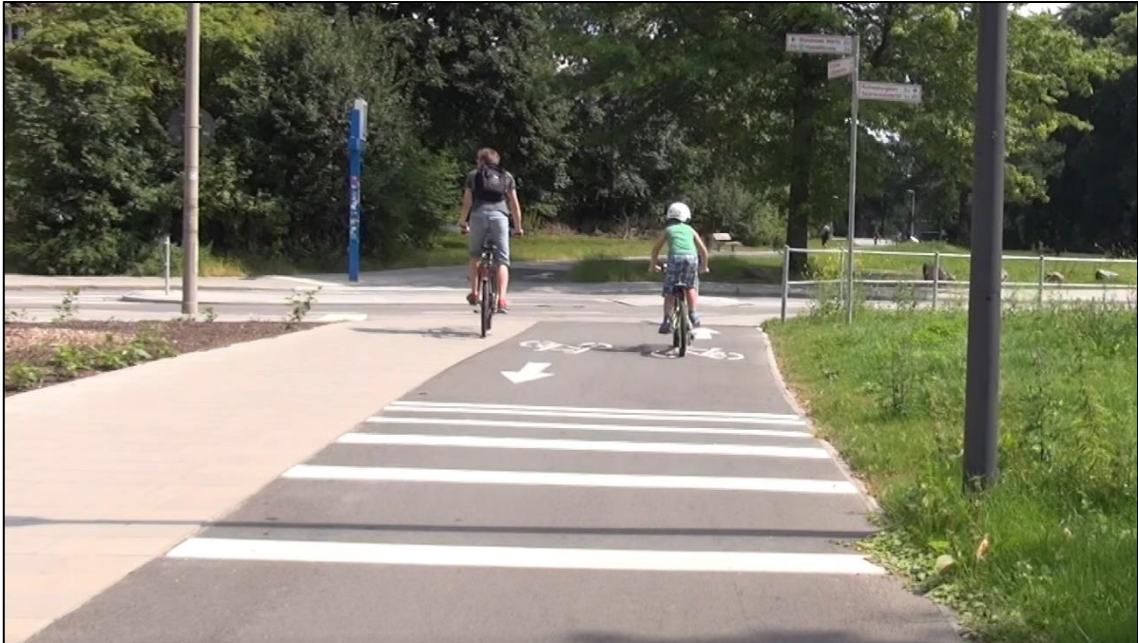
Abbildung: Beispiel einer Dickschichtmarkierung zur Erhöhung der Aufmerksamkeit von Radfahrern in Hamburg
