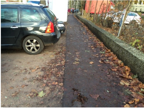
Abbildung 2: Gehweg, südöstliche Nebenflächen
