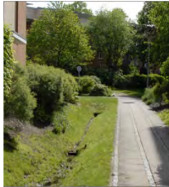
Beispiel für die Ableitung von Regenwasser in Gräben, Rinnen und Mulden (Bild links wassersensible Stadt Bremen,2014 , Bilder rechts Birco,2020)
