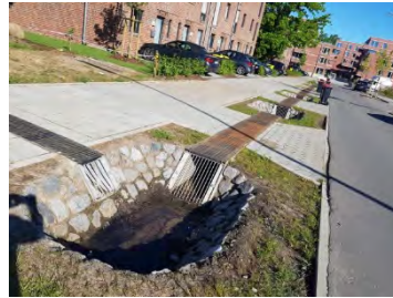
Beispiel für die Ableitung von Regenwasser in Gräben, Rinnen und Mulden (Bild links wassersensible Stadt Bremen,2014 , Bilder rechts Birco,2020)
