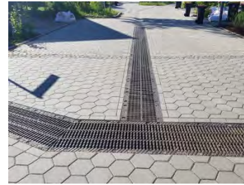
Beispiel für die Ableitung von Regenwasser in Gräben, Rinnen und Mulden (Bild links wassersensible Stadt Bremen,2014 , Bilder rechts Birco,2020)
